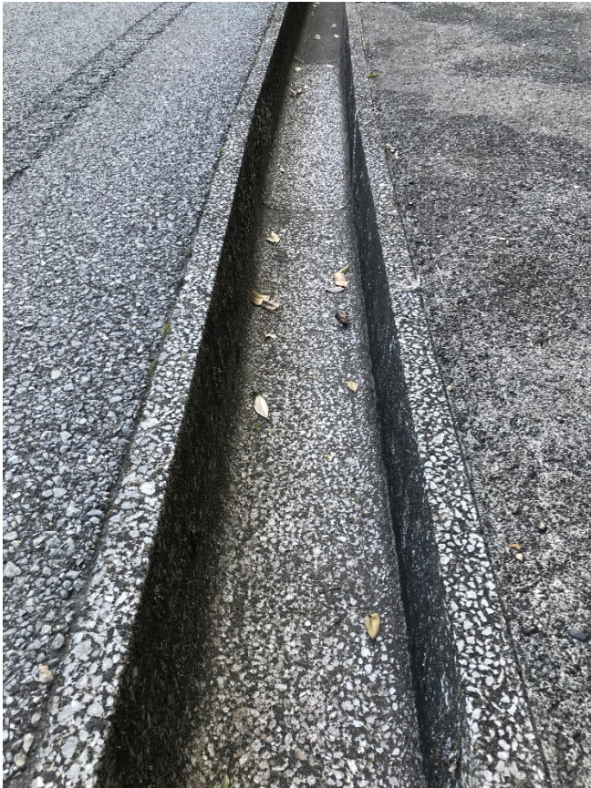
図 17. 高速信号の伝送は U 字溝に水を流したものと同一（水は流れていない写真だが。また別にこんな写真を掲載しなくてもよいものだが…）
