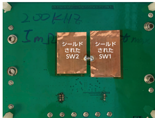
図4. DHLの最下層のスイッチング・ノード。SW1とSW2にシールドを施しています。
